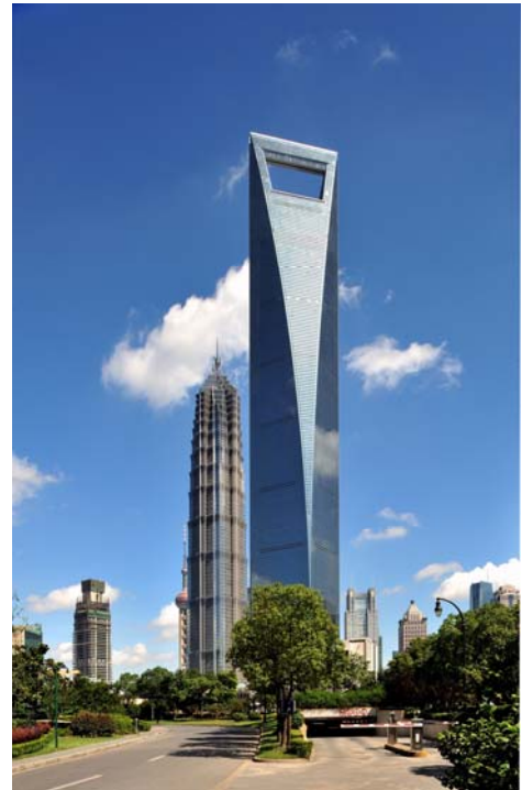
Shanghai World Financial Center Aufzüge von ThyssenKrupp mit 10 m/s.
